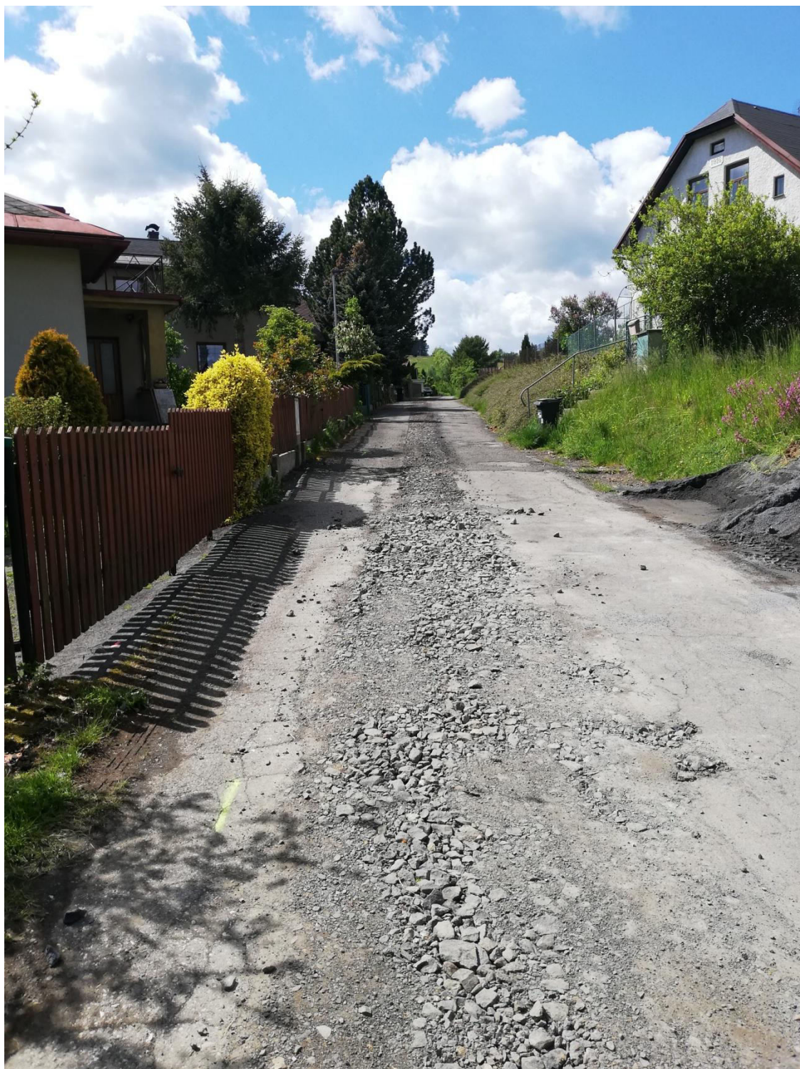
Foto z výstavby vodovodu na Sídlišti
