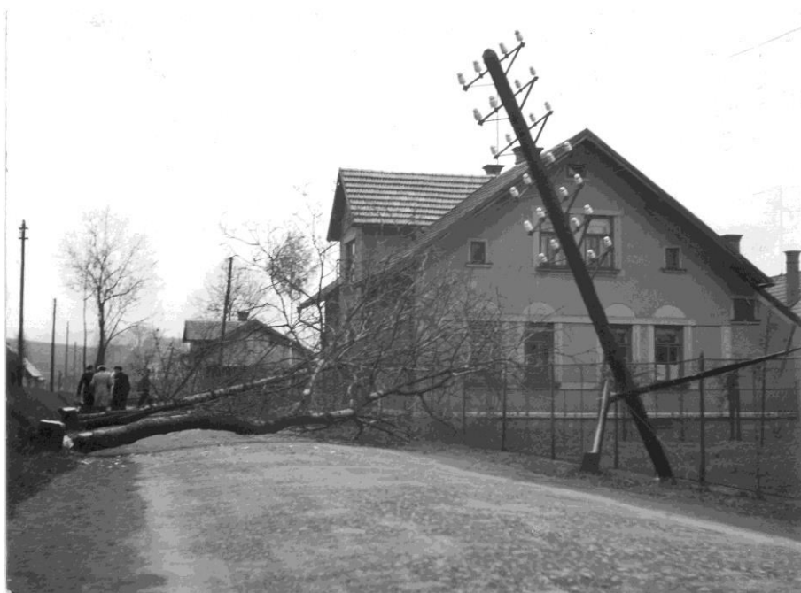
Poražené stromy a sloupky elektrického vedení v době květnového povstání v Chuchelně. (SOKA Semily, SbF, sign. III - 266, 3. května 1945, autor neznámý)
