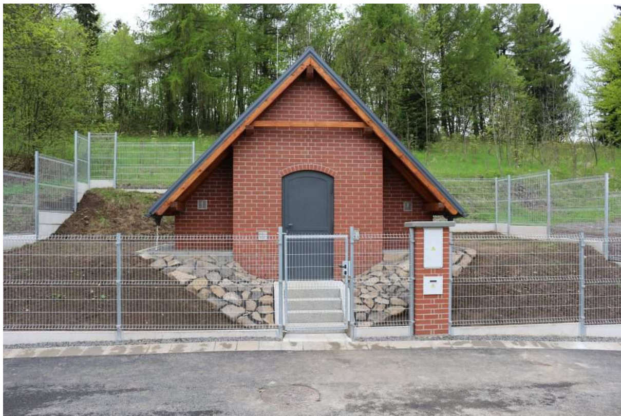
Nový vodojem na Komárově
