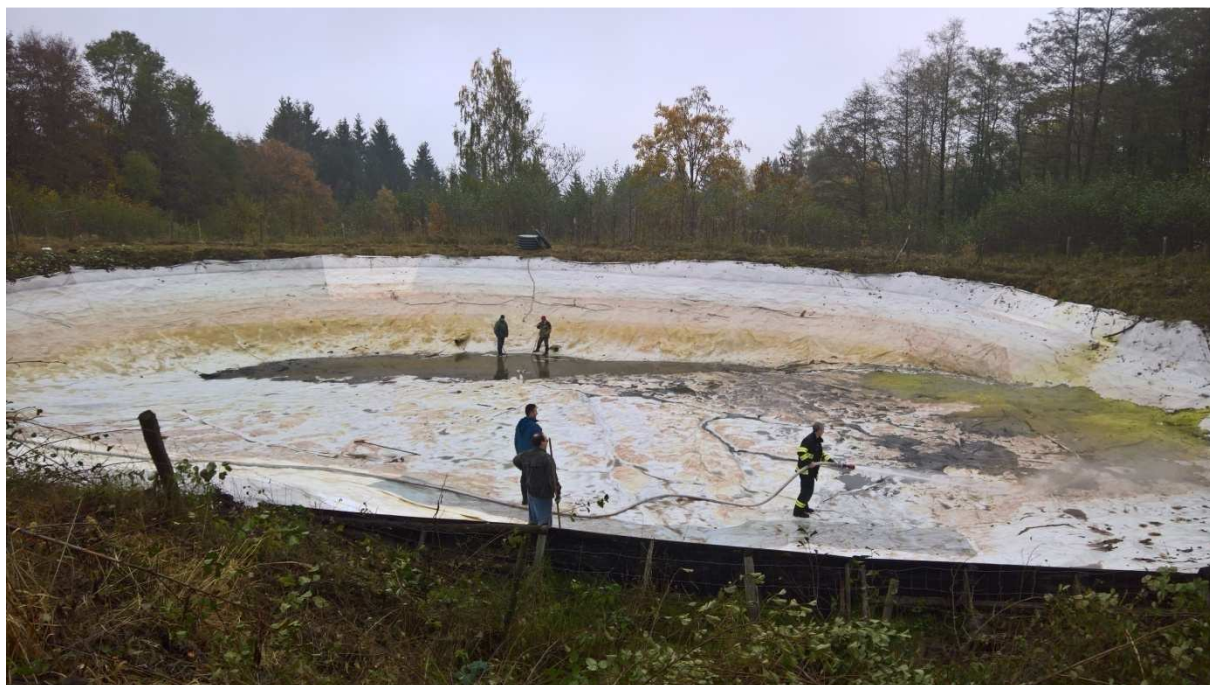
Čištění zasněžovací nádrže
