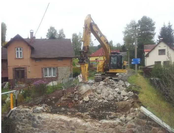
Bourání mostu u školy
