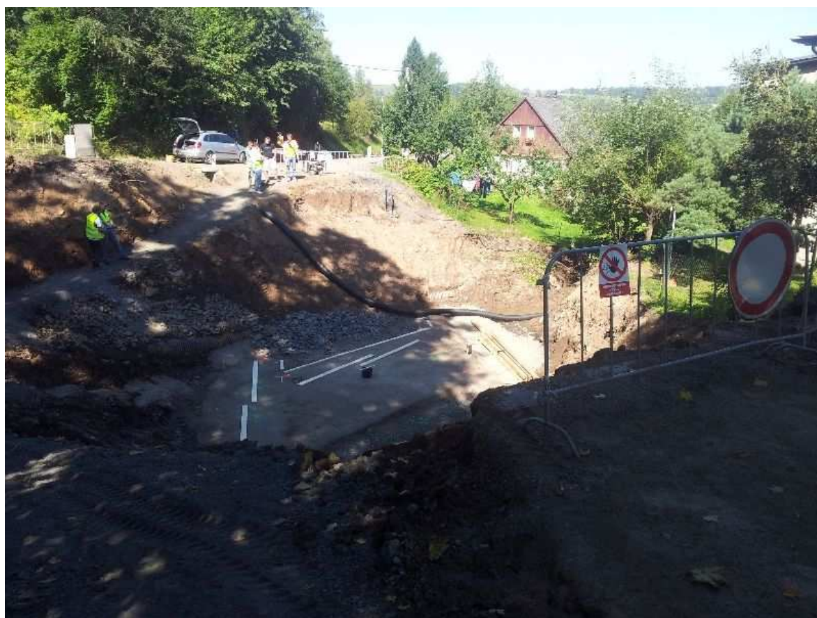
Situace po odstranění mostu v Palučínách
